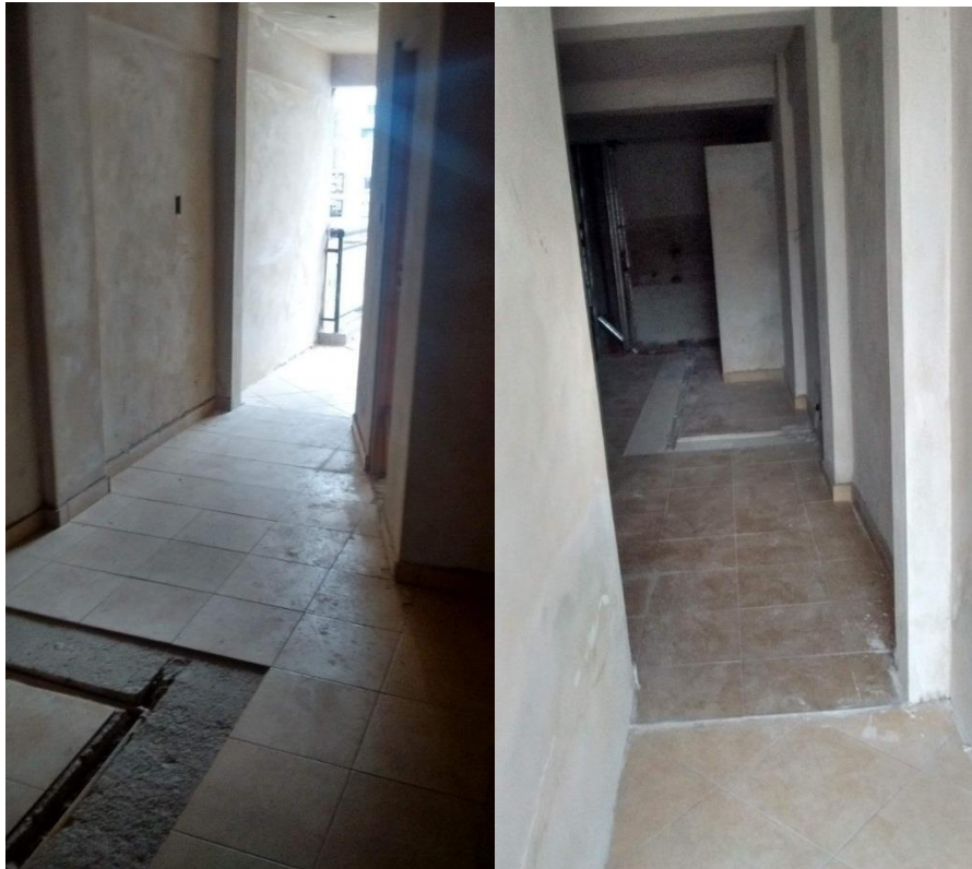
Imágenes: Estar-Comedor colocación de piso, excepto en la parte de instalación de cañería de gas. Falta pintura en muros.
