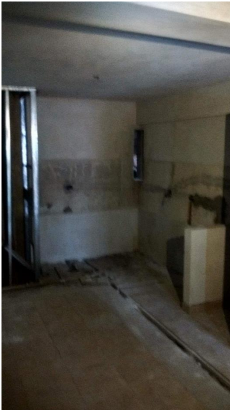
Imágenes: Estar-Comedor, con faltante de equipamiento de Cocina, pintura y cerramiento de columna montante.
