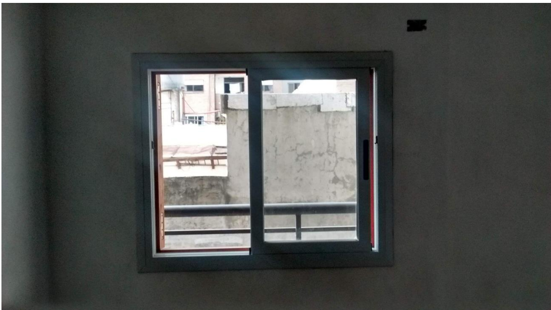
Imagen: Ventana del Dormitorio, vista desde el interior del mismo.
