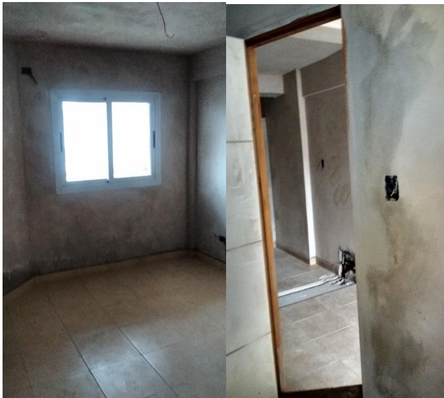
Imágenes: Dormitorio con piso, zócalos, ventana y puerta colocados. Pintura y artefactos de electricidad faltantes.
