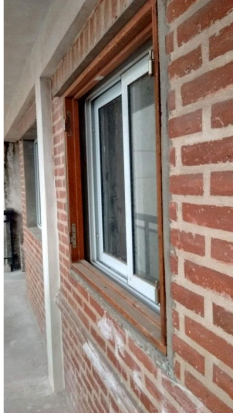
Imágenes: Balcón, con parte de piso colocado, recubrimiento de muro con ladrillo. Falta persiana de madera.
