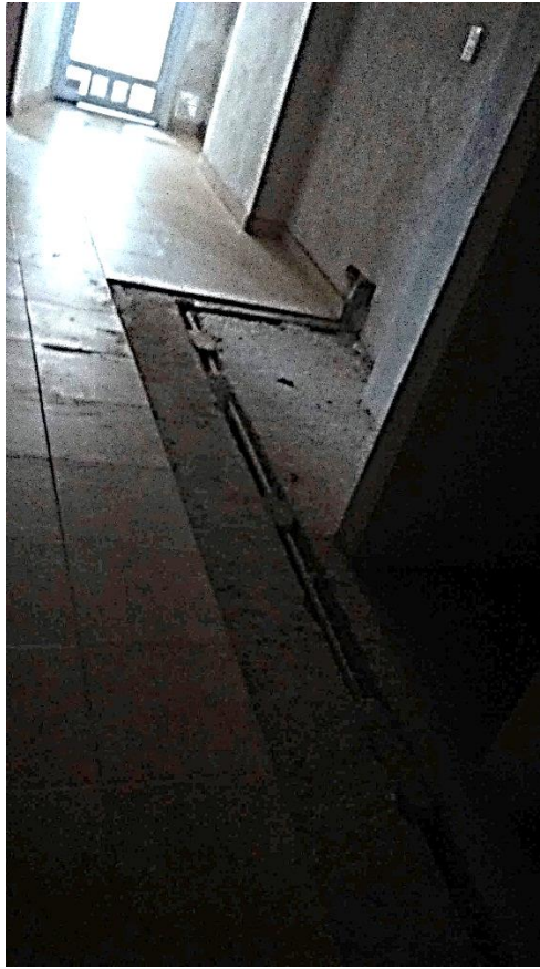
Imagen: Parte del piso colocado en Estar-Comedor y Pasillo.
