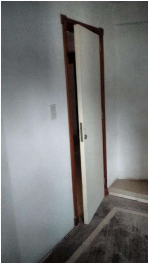
Imágenes: Dormitorio, donde se observa, piso de parquet colocado, placard, puerta sin picaporte y marco colocados. Tomas corrientes colocadas.
