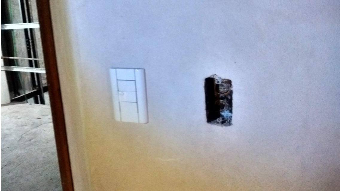
Imagen: Ingreso al Departamento, zona Estar – Comedor, se muestra parte de la instalación eléctrica terminada y otra no.
