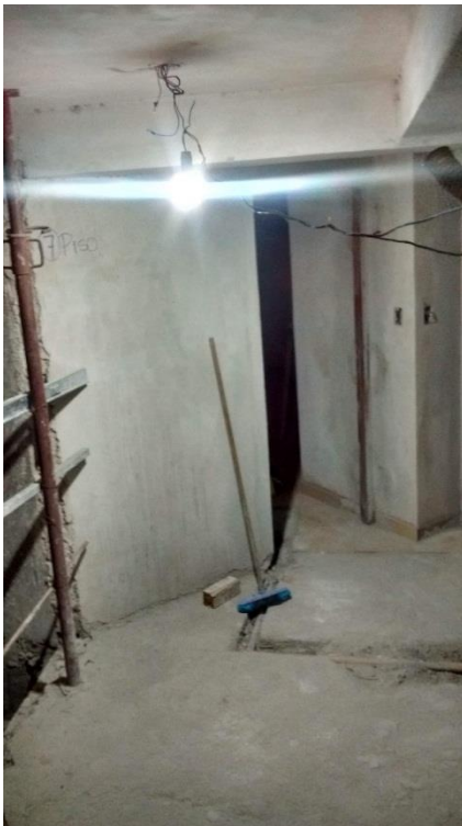
Imágenes: Palier de Ingreso al Departamento, puerta sin colocar. Tablero eléctrico e instalación sin terminar. Pintura de todo el Dpto. sin aplicar.
