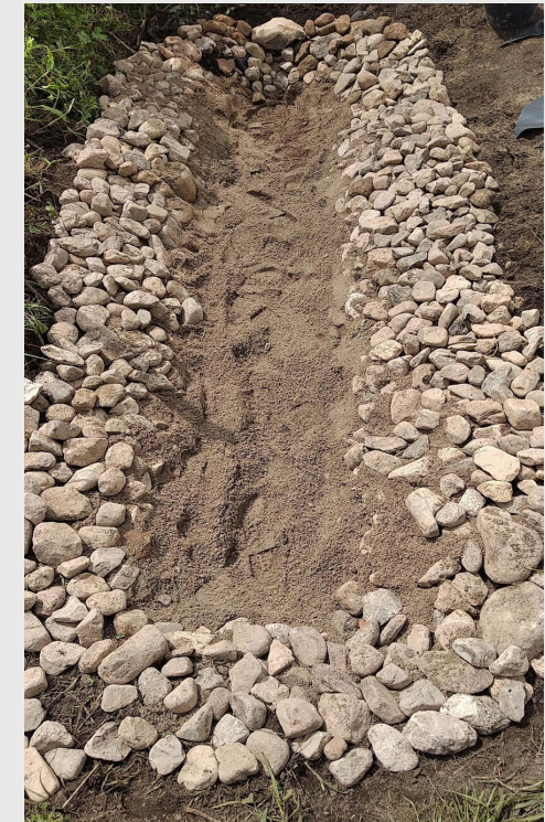
GRANZA 10-30 en ingreso y salida -3:5 en el centro + CAPA TIERRA 5CM
